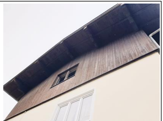
Dachüberstand 2 und Holzverschalung
