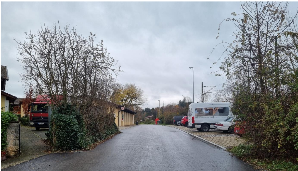
Bildausschnitt Google Maps – Testanlage Straßenbeleuchtung im Simsseeweg Bad Endorf
