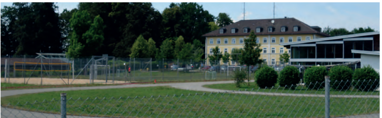
Blick auf die Bundespolizeiportschule
