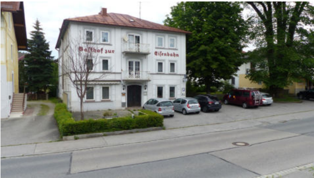
Rosenheimer Straße, Zugang Ortskern im Westen
