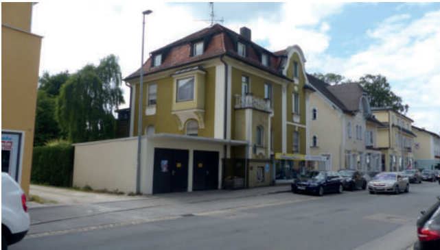
Rosenheimer Straße, Zugang Ortskern im Westen
