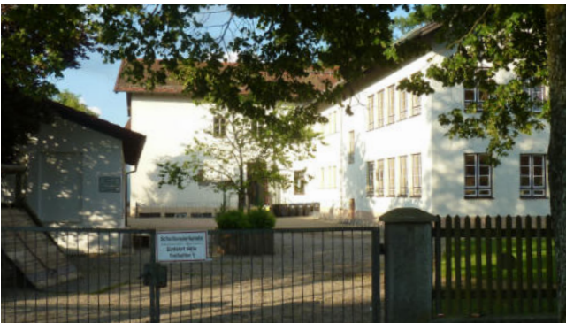
Sanierungsbedürftiges Grundschulgebäude, Schulstraße
