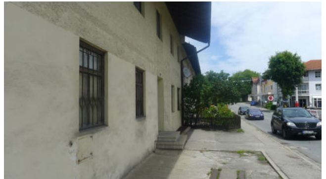
Ehem. Raiffeisengebäude an der Ecke, Traunsteiner Str.
