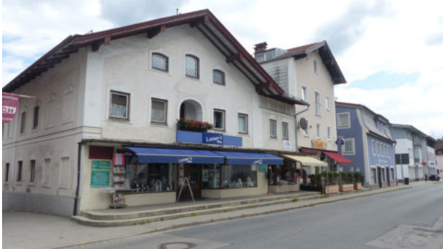
Rosenheimer Straße, Zugang Ortskern im Westen
