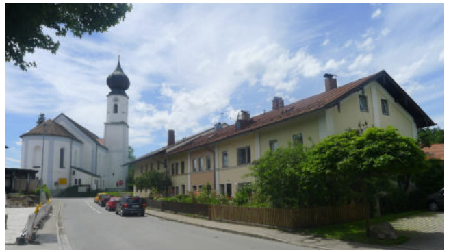
Wasserburger Straße, Blick auf Kirche, rechts prägende histor. Reihenhäuser
