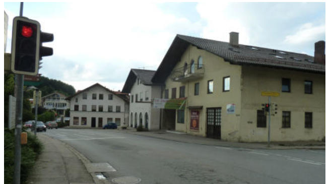
Prägende giebelständige Bebauung am Kirchplatz, beide leerstehend
