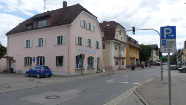
Sanierungsbedürftiges Haus d. Gastes, Bahnhofstraße / Raiffeisenweg
