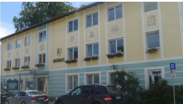
Sanierungsbedürftiges Rathaus, Bahnhofstraße
